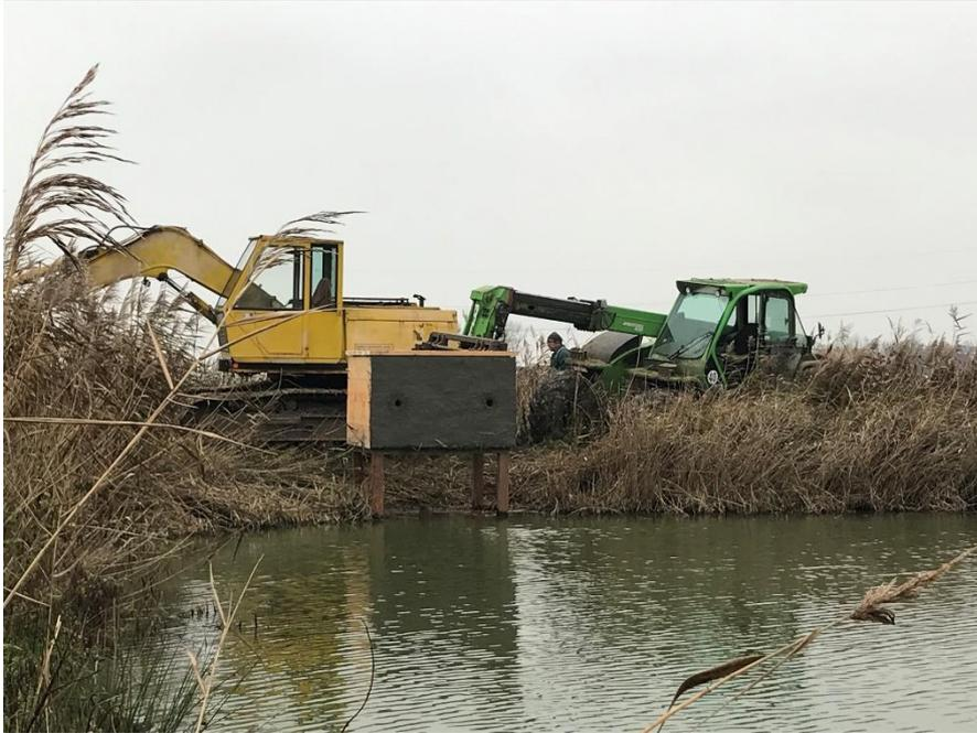
dem kleinen Teich installiert. Diese besteht aus einer selbstgebauten Holzkiste, die zum überwiegenden Teil mit Kleiboden gefüllt ist. In dem Kleiboden sind zwei vorgefertigte Röhren mit jeweils einer Brutkammer eingebaut, die wiederum mit Klei ausgestattet sind, um eine möglichst natürliches Umfeld zu imitieren. Die Konstruktion steht im Uferbereich auf einem
